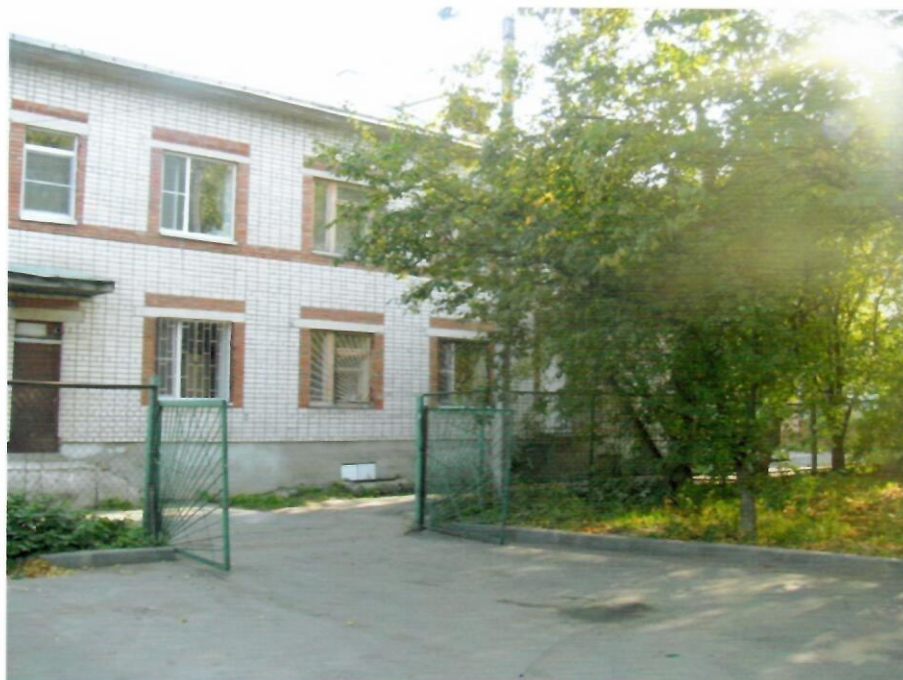
Подъезд к дошкольному учреждению с улицы Герцена
